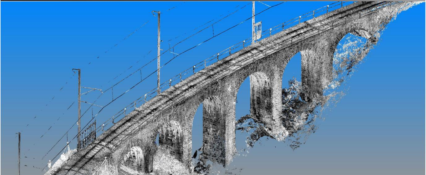
Für die geplante Brückensanierung vom Truntobelviadukt hat die HMQ AG Aufnahmen mittels 3D-Laserscanning ausgeführt. Dieses Messverfahren garantiert eine präzise und verformungsgerechte Erfassung der Brückengeometrie.
